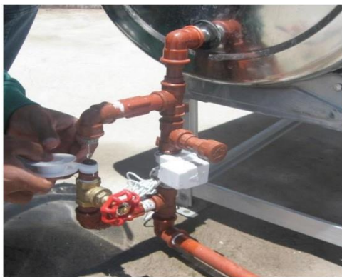
Figura 4. Colocación del sensor de presión.
