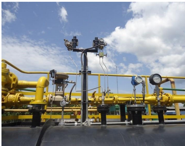
Figura 3. Medidor de interfase de onda guiada.
