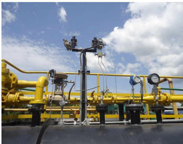
Figura 3. Medidor de interfase de onda guiada.
