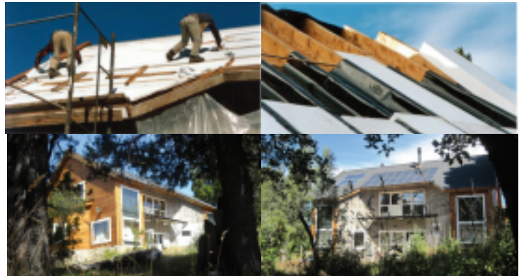
Figura 6. Incorporación de 200 mm de aislante liviano en el techo, sistemas solares y paneles fotovoltaicos, en un clima frio de altura.
