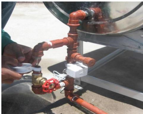
Figura 4. Colocación del sensor de presión.
